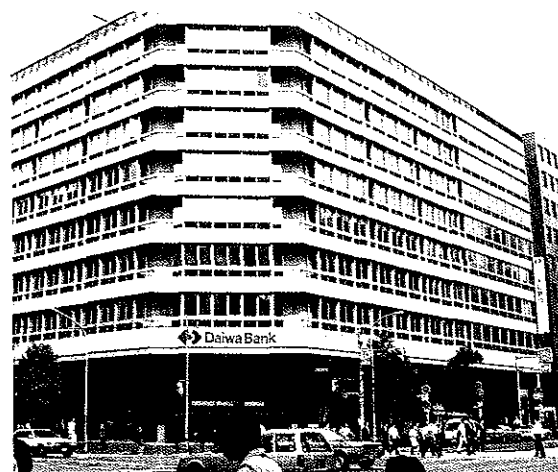
▲船員雇用促進センターのある大和虎ノ門ビル
