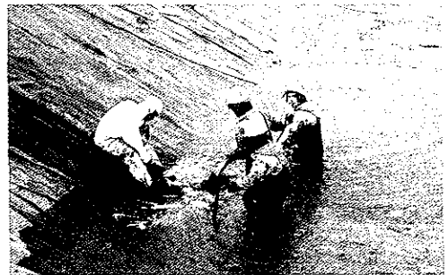
▲ドラム缶不足により急遽ピット（約30m×40mの穴）に収容された回収油はバキュームポンプ、バキュームカーを介し、内航船に積み込まれ、焼却処分所に輸送される。C重油は高粘度のため、ケロシンを混ぜながら吸引。（1月15日）
