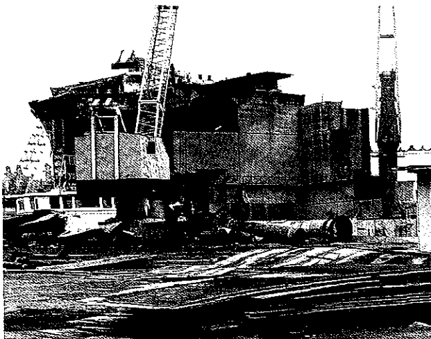
▲長江折船廠（解撤ヤード）における解撤作業現場
