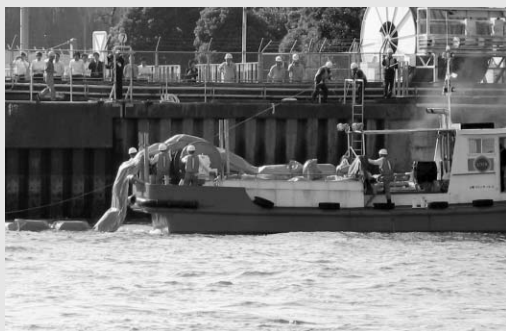
▲オイルフェンスを張る様子
