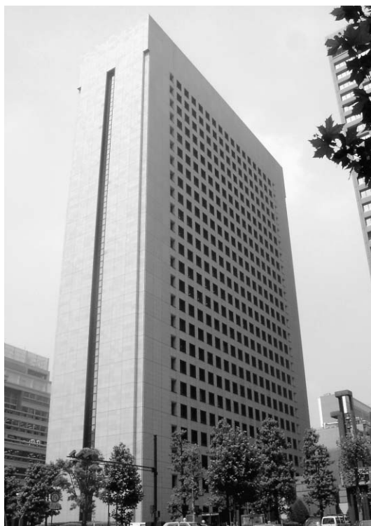
▲本社の入居する日比谷セントラルビル外観
