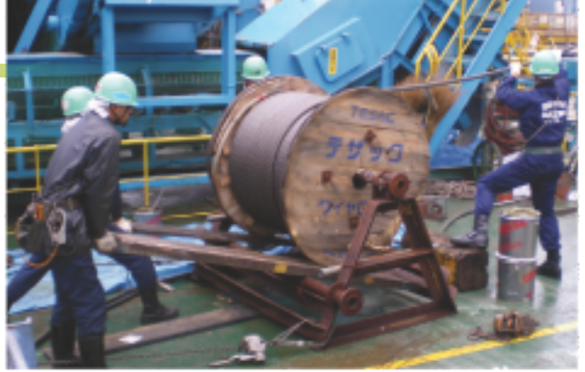
作業船ワイヤー新替作業(サンドドレン)風景
