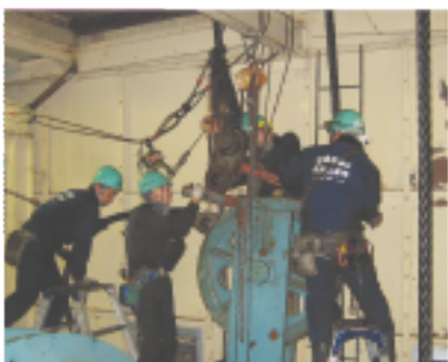
120tクレーンワイヤー新替作業風景1
