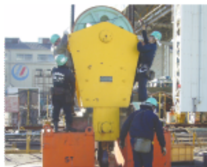
120tクレーンワイヤー新替作業風景2
