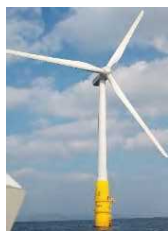
浮体式洋上風力発電 (長崎県五島市沖)
