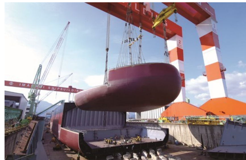
大型ゴライアスクレーン(吊能力800トン)
