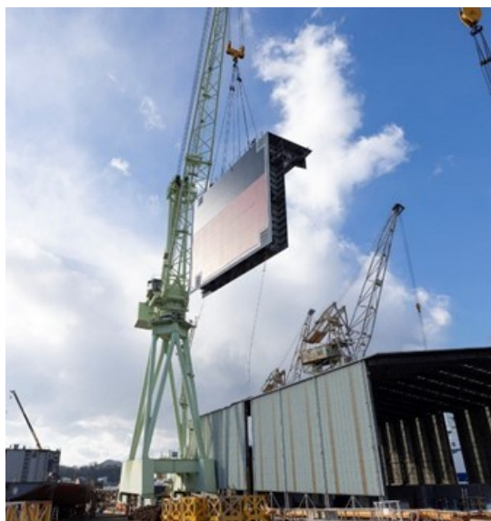
ジブクレーン(吊能力が低い)
