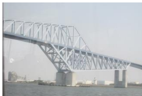
▲海上から見た東京ゲートブリッジ
