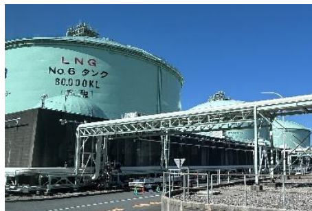
バス車内から見学した LNG タンク
